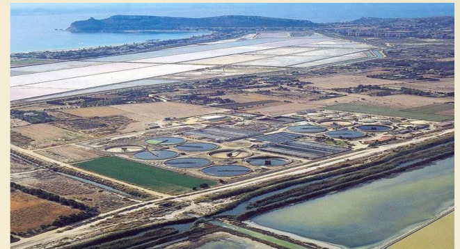
depuratore di Is Arenas - Cagliari
