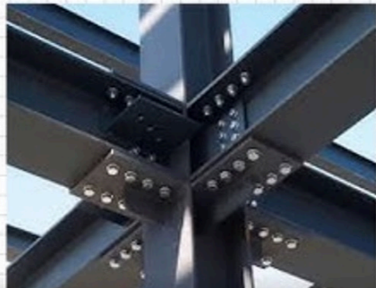
Realizzazione pratica di un vincolo INCASTRO INTERNO
