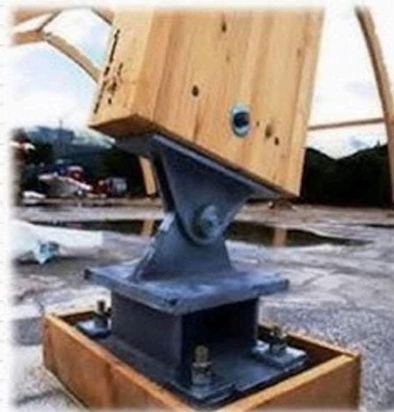
Realizzazione pratica di un vincolo CERNIERA
