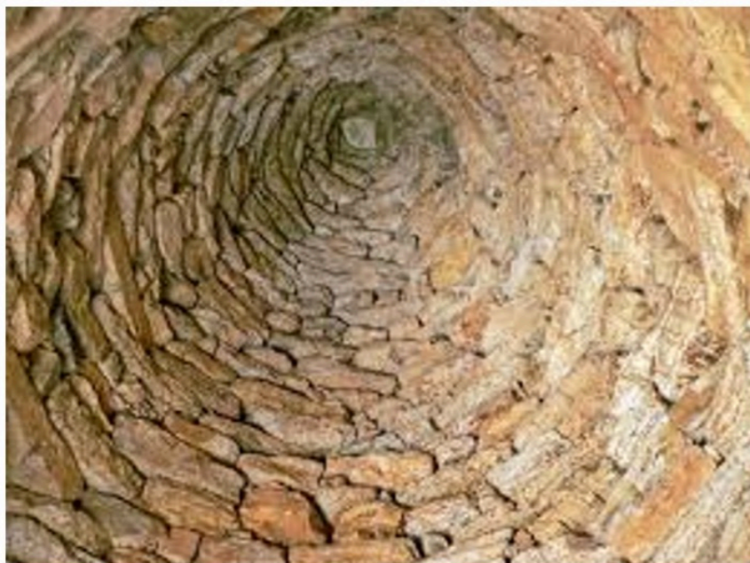
Copertura a tholos di un ambiente all'interno di un nuraghe.
