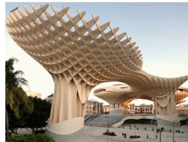
Metropol parasol, Siviglia arch. Jurgen Maryer. (la più grande struttura al mondo in legno lamellare)
