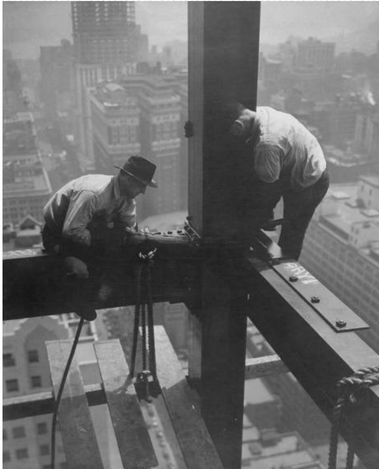
Operai al lavoro su travi per la costruzione di un grattacielo, NY
