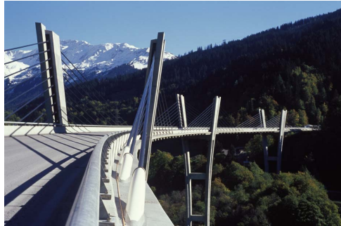
Sunnibergbrücke, Ch. Menn
