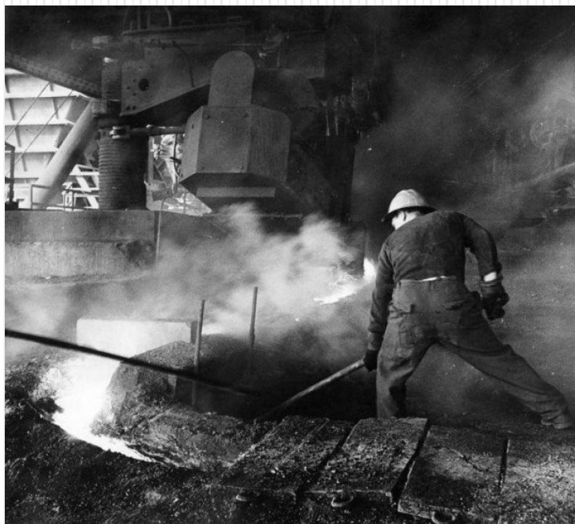
Bagnoli, Stabilimento ILVA
