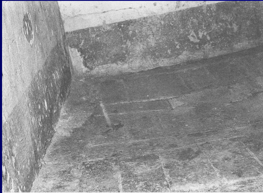
Estradosso solaio in legno con depressione orditura portante (Immagine tratta da Munafò, op. cit.)
