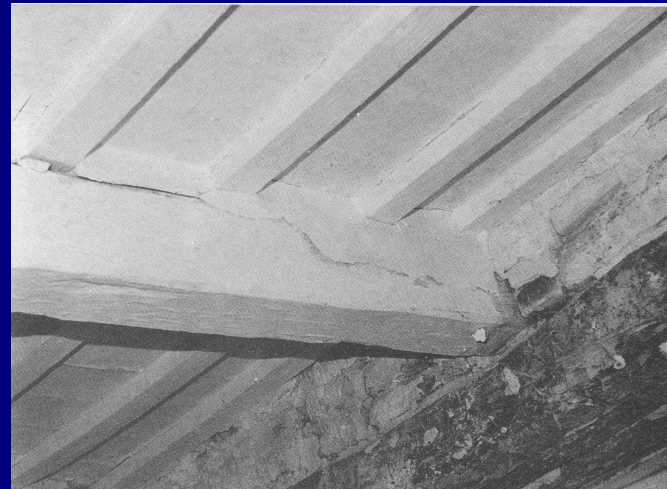
Lesioni a taglio in prossimità degli appoggi Immagini tratte da Munafò, op. cit.
