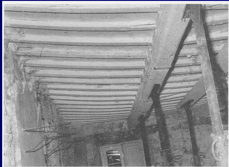
Intradosso solaio in legno con depressione orditura portante (Immagini tratte da Munafò, op. cit.)
