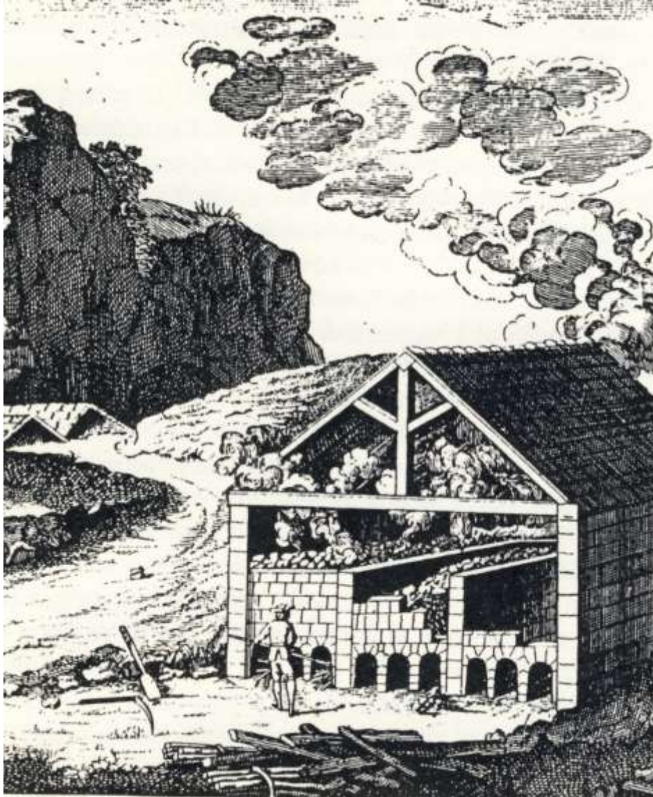
Forno per la cottura del gesso ad alta temperatura in Germania, in opera fino al 1930
