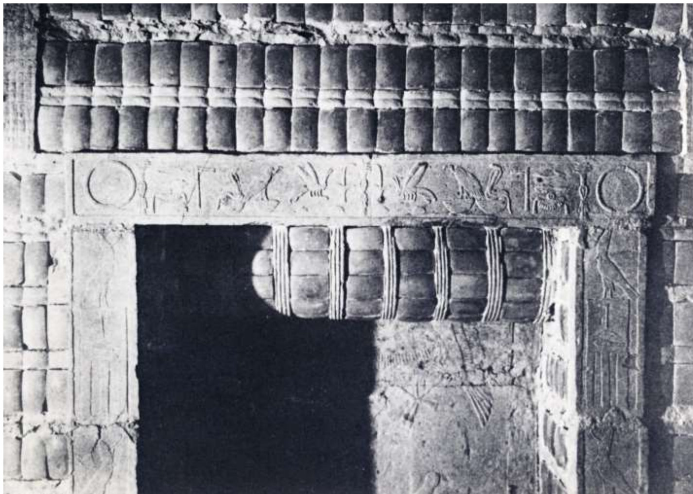
Tomba del complesso Zoser (Antico Egitto, III millennio a.C.); i fregi scolpiti sulla pietra richiama le costruzioni in materiali vegetali.
