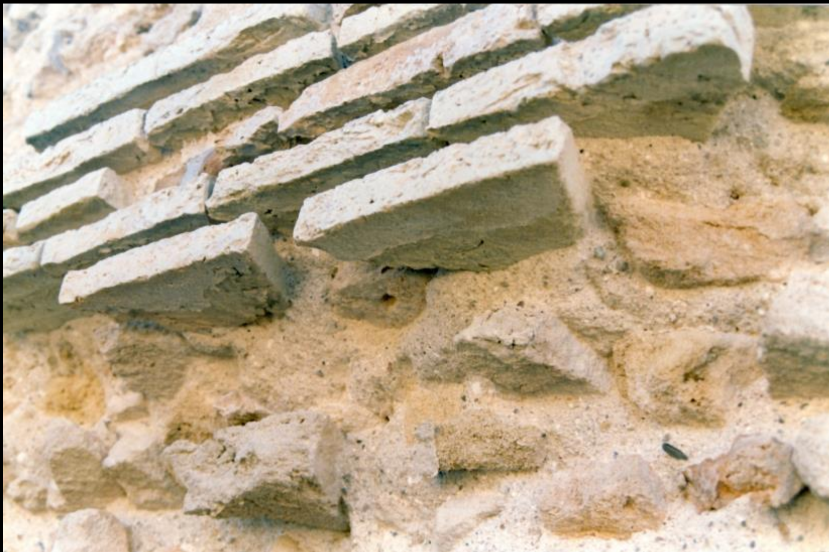
Particolare di una muratura.
