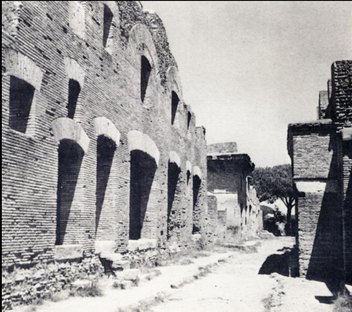
Facciate in mattoni ad Ostia (II secolo d.C.)
