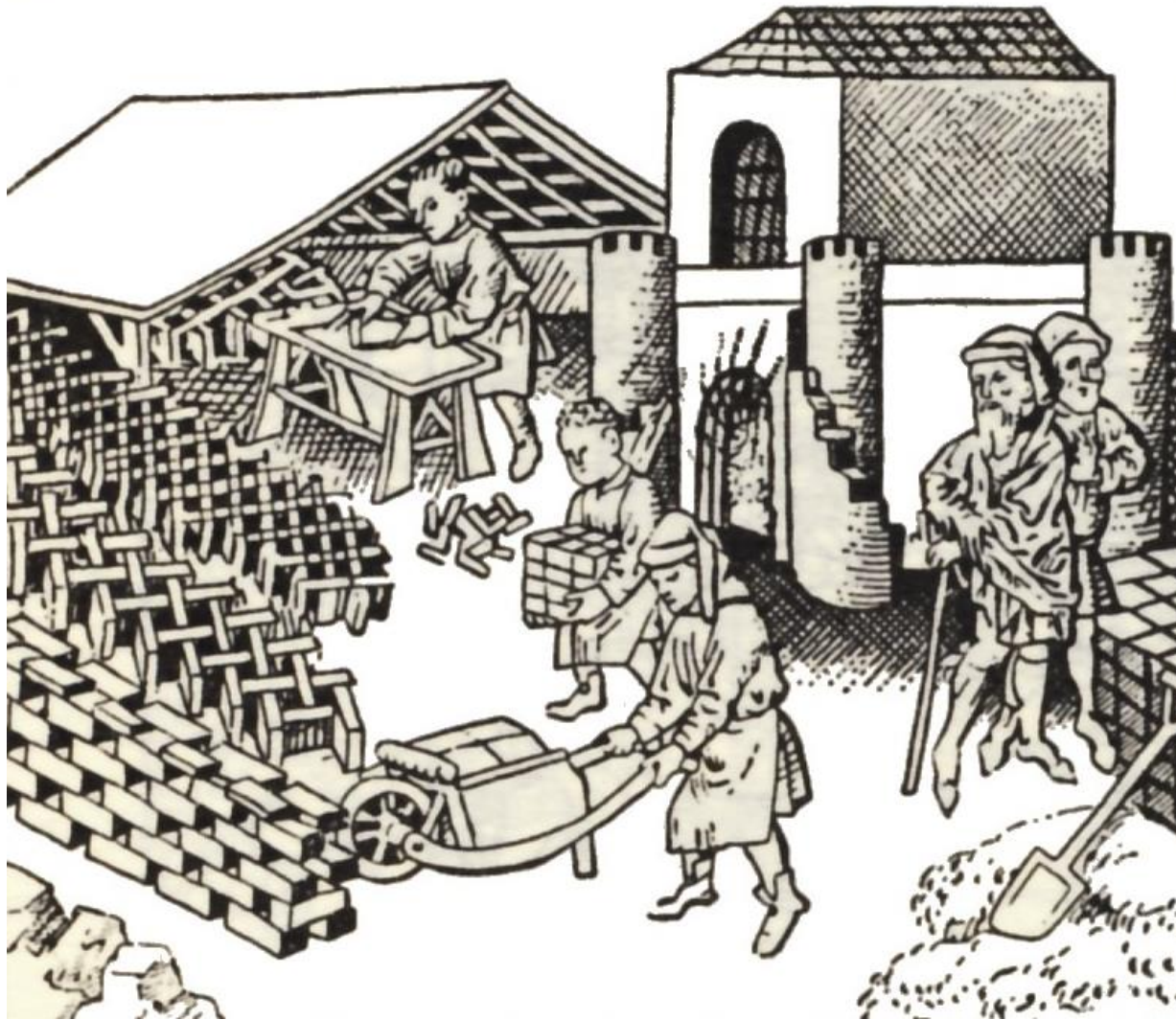
Preparazione ed essiccamento di mattoni in Europa nel XV secolo.
