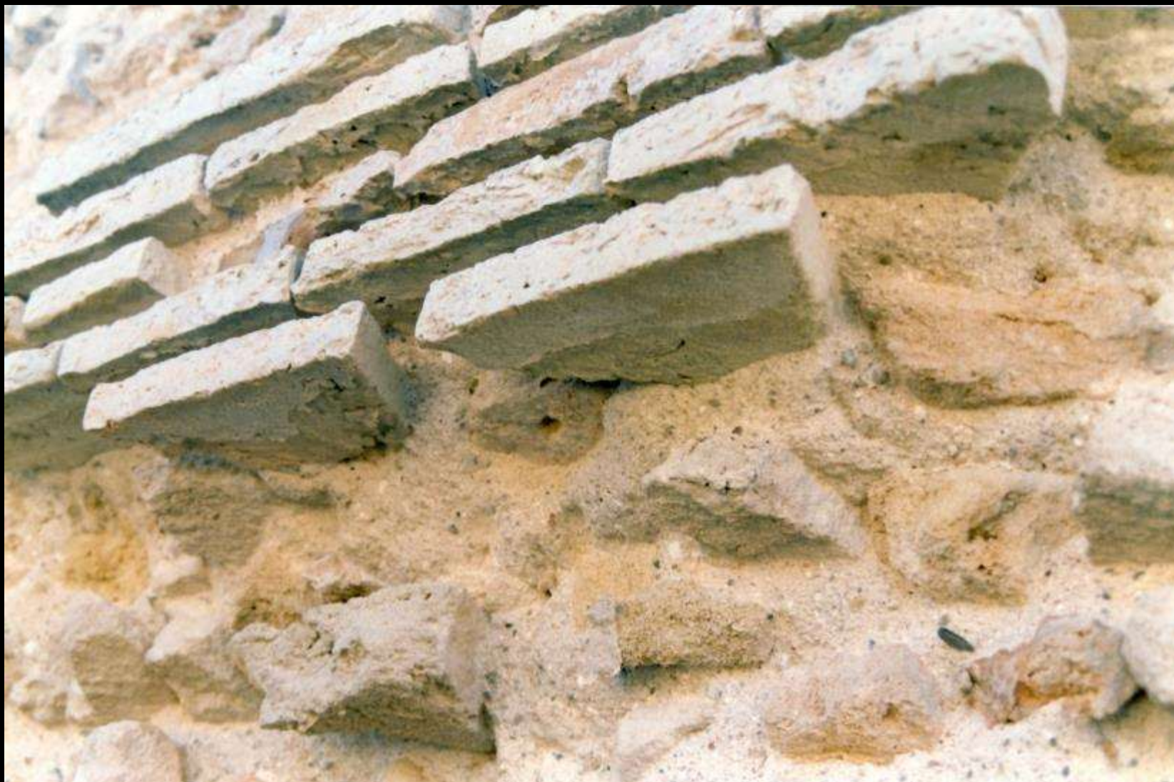
Particolare di una muratura.
