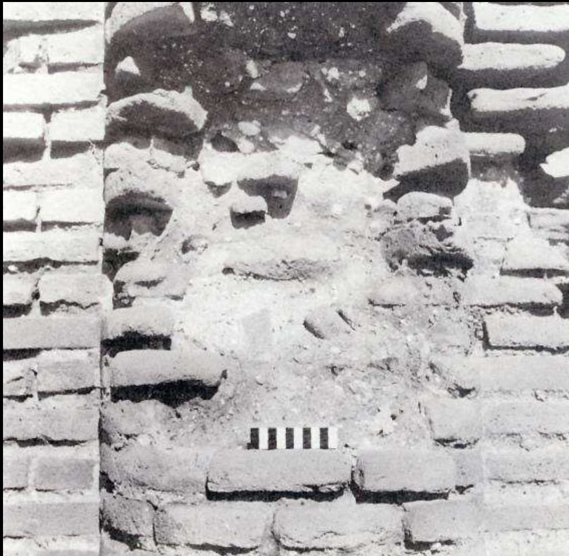
Muratura romana a sacco.
