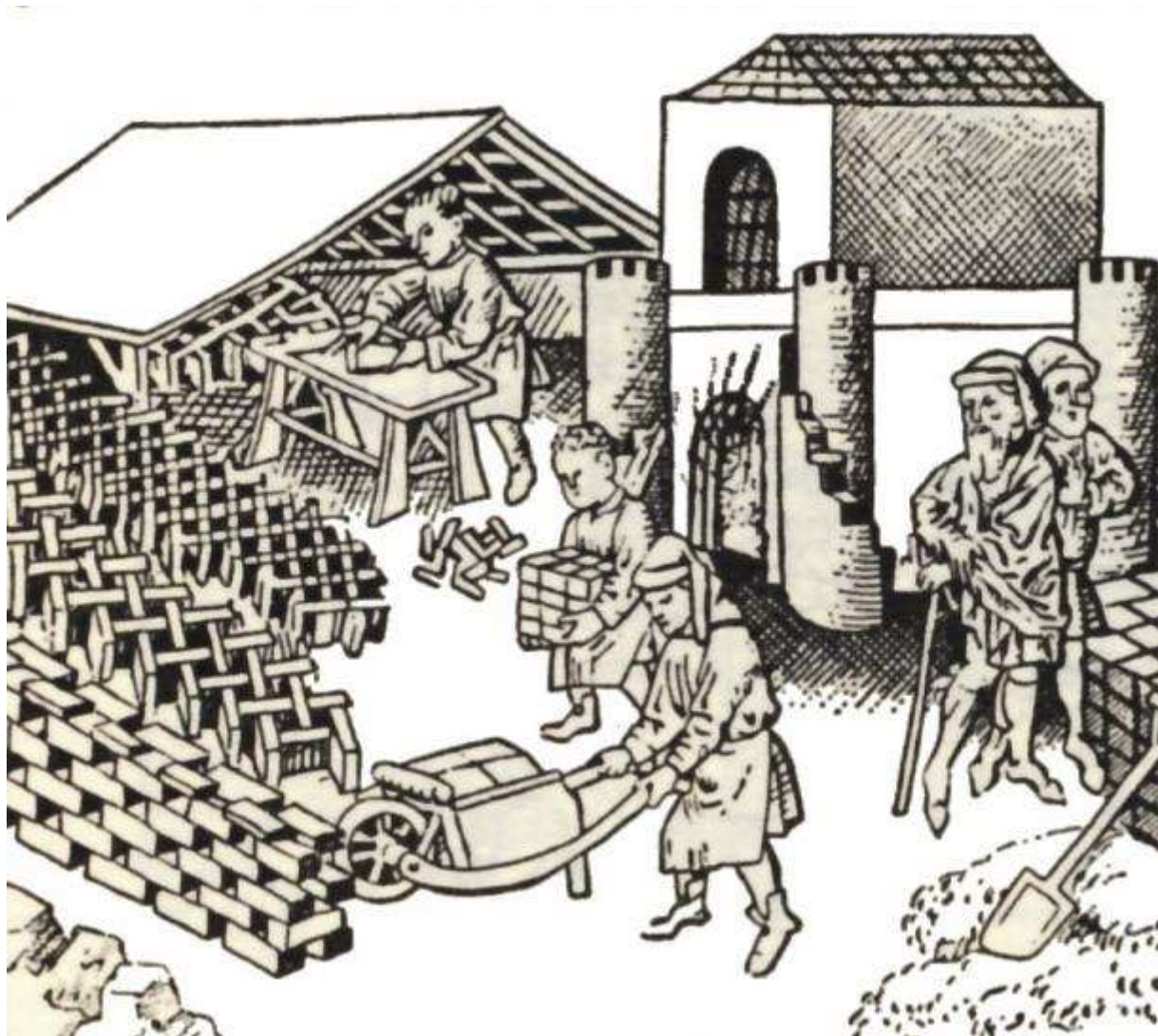
Preparazione ed essiccamento di mattoni in Europa nel XV secolo.
