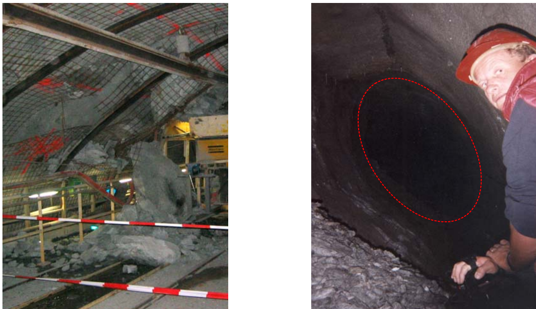
Fig.3.1: Esempio di fenomeni di decompressione violenta [sx: Galleria del Loetschberg (Diederichs, 2005)] e di comportamento spingente [dx: deformazione del cunicolo pilota della galleria ferroviaria di Fleres scavato con TBM nel 1987-1988 (foto del 1993, cortesia del Dr. S. Pedemonte)]
