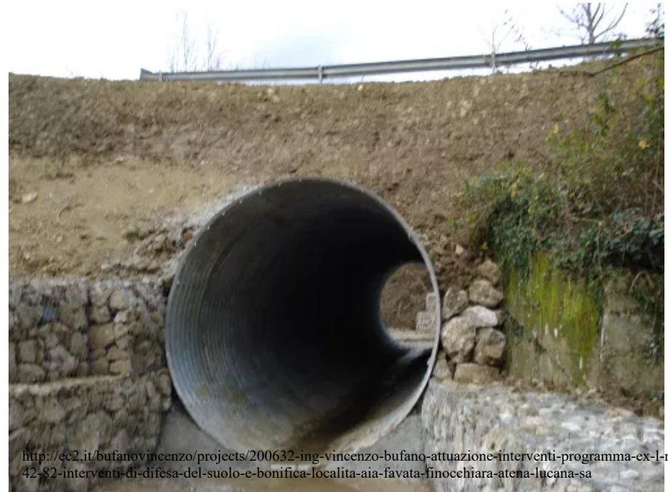
Tombino a sezione circolare in lamiera ondulata
