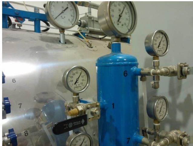
Figura 29: Rubinetto 1 in posizione "via vento"
