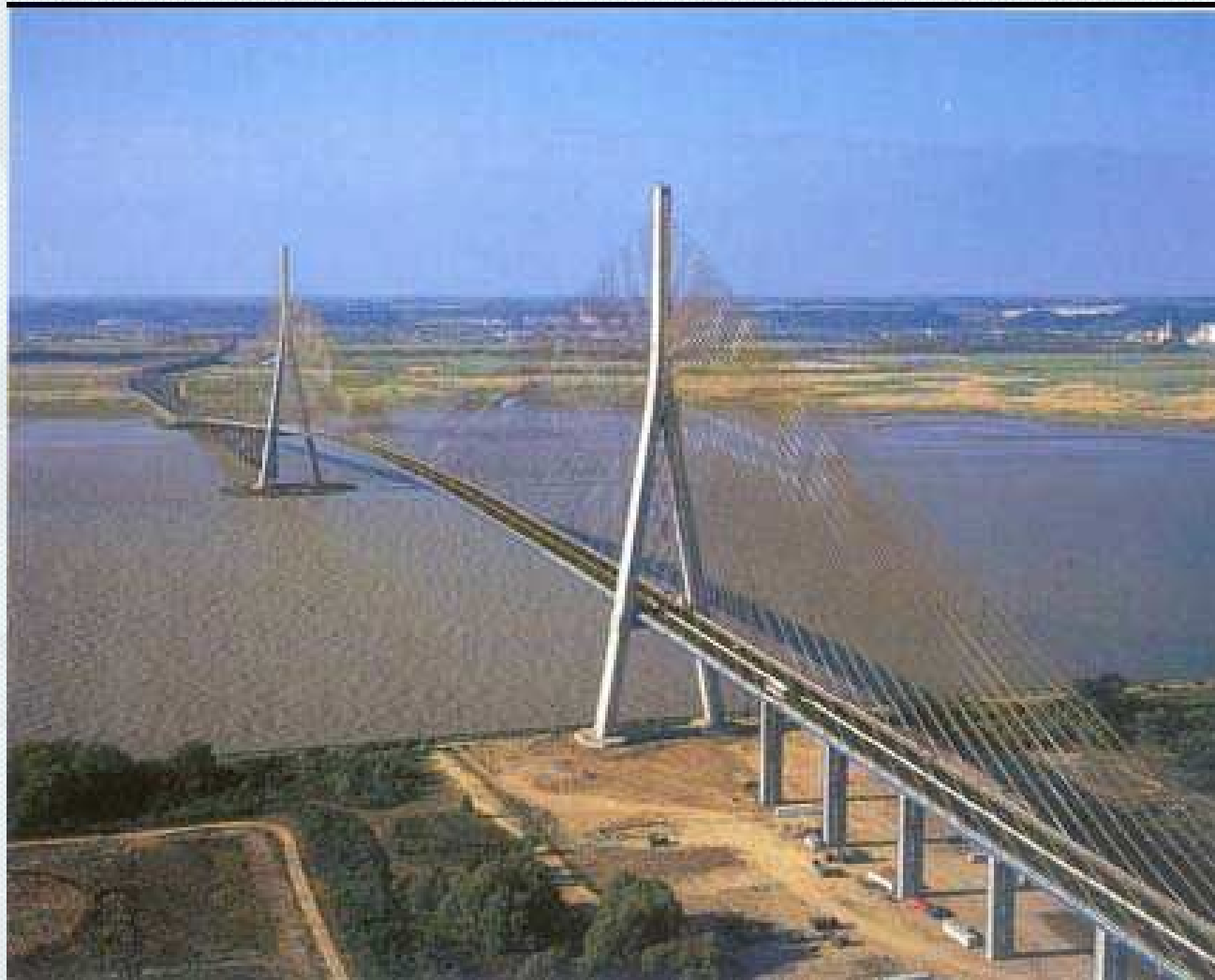
Ponte di Normandia (M. Virlogeux, 1988-95, 865m) schema misto
