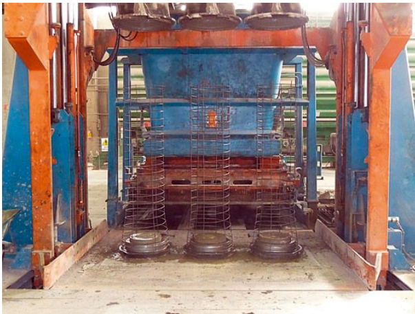
armatura predisposta per il getto
