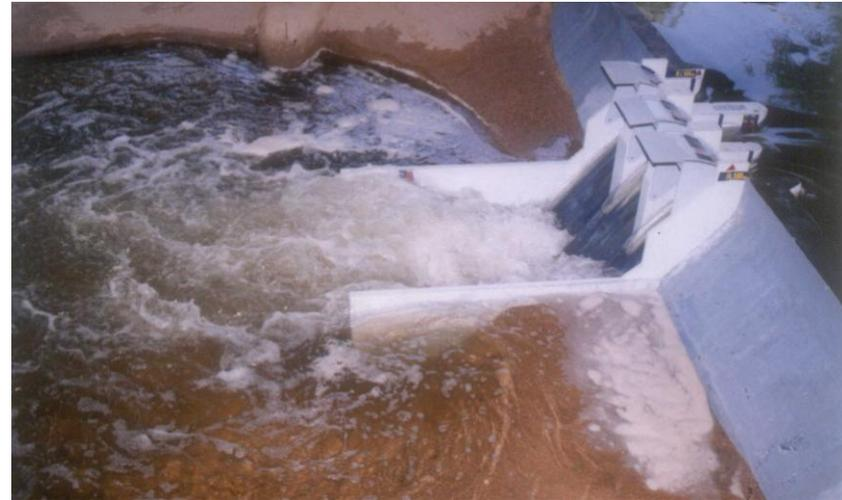
Risalto provocato in uno scarico da una diga per dissipare energia, ridurre l'erosione e quindi mantenere stabile la diga stessa
