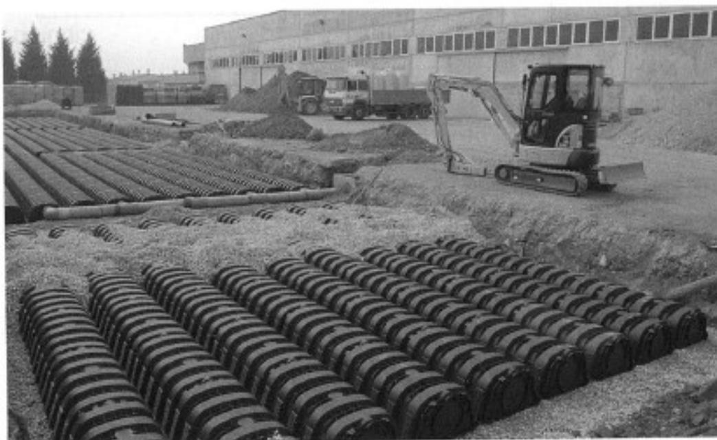
Fig. 102 – Esempio di sistema alveolare disperdente
