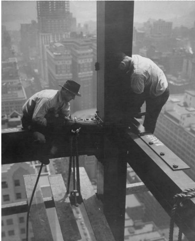
Operai al lavoro su travi per la costruzione di un grattacielo, NY
