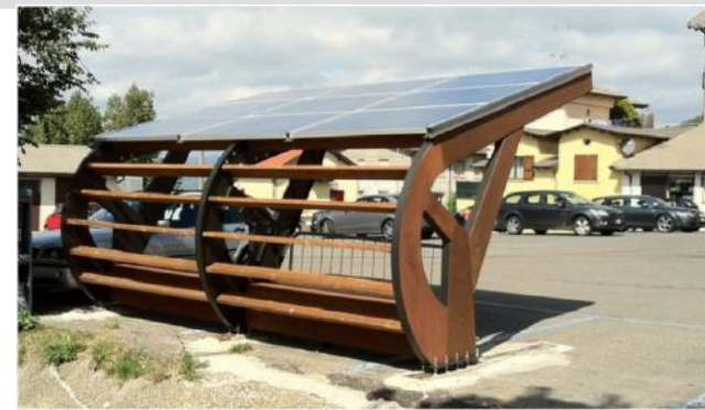
Figura 3.3 Pensilina fotovoltaica a Roma (Fonte: http://www.archilovers.com/p66865/PENSILINE-FOTOVOLTAICHE-bike-sharing )
