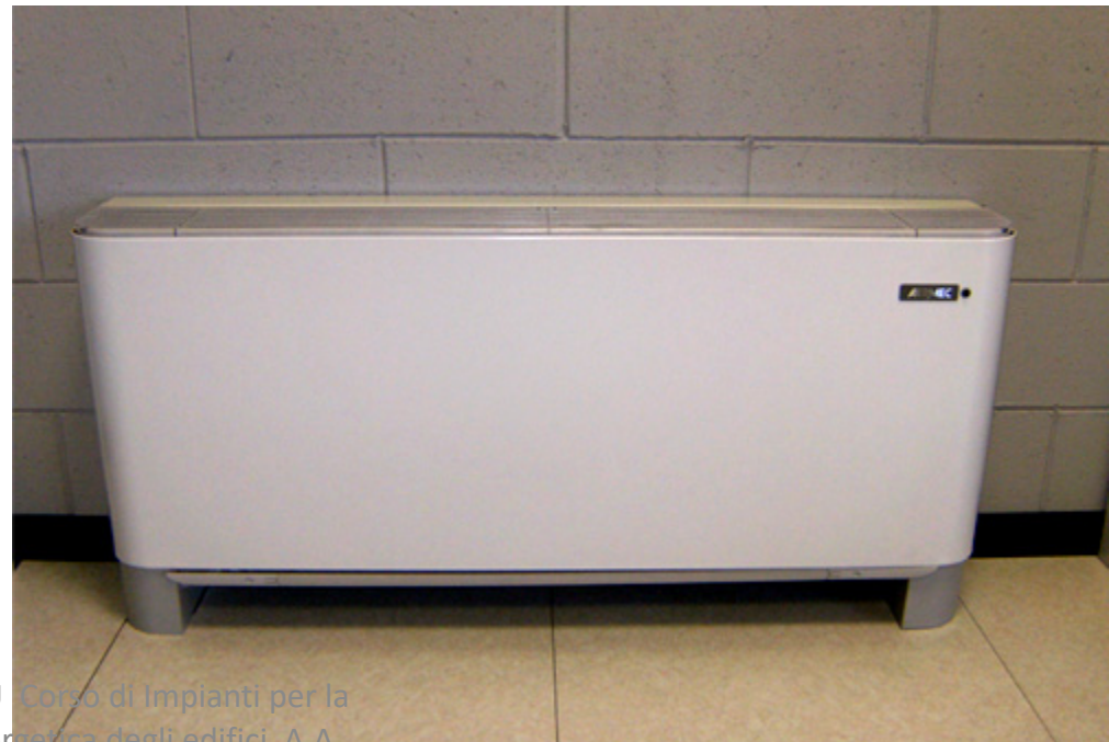
Ventilconvettori / Termoconvettori
